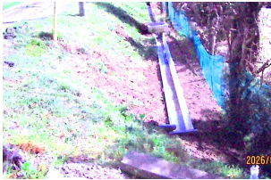
新設したU字溝
