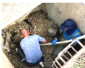
土管内の土砂撤去作業
